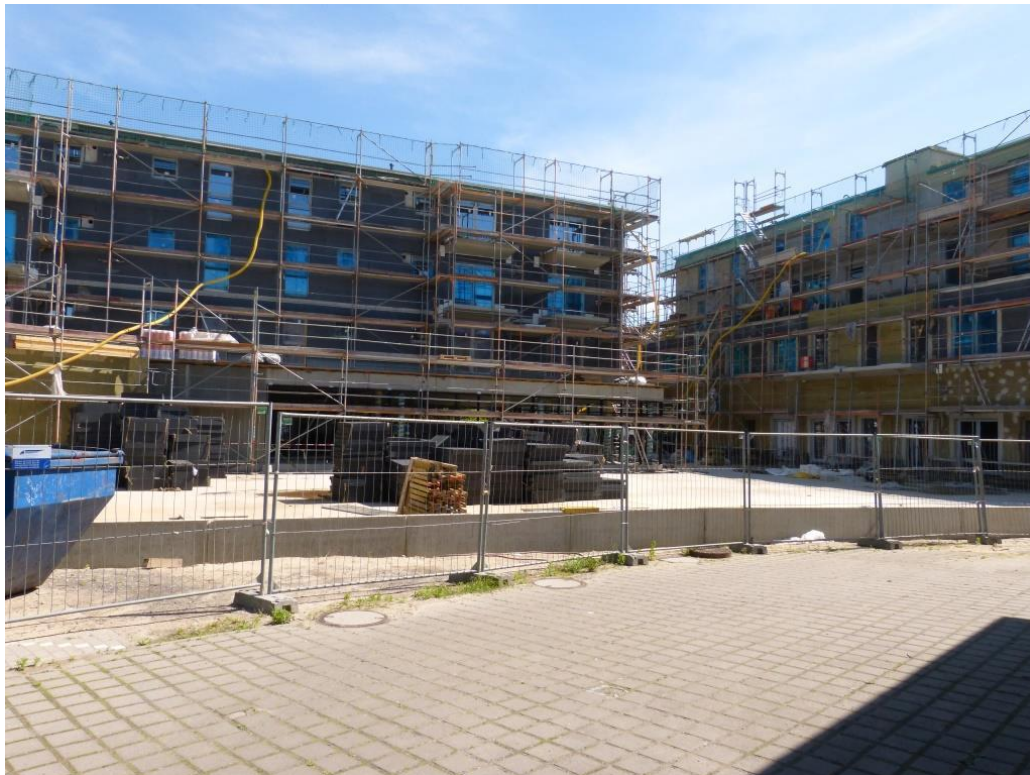
Bild 4: Blick von Süden Gebäude in 2. Reihe nördlich der Poststraße
