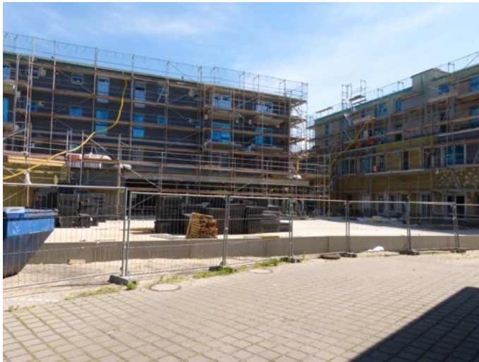
Blick von Süden Gebäude in 2. Reihe nördlich der Poststraße
