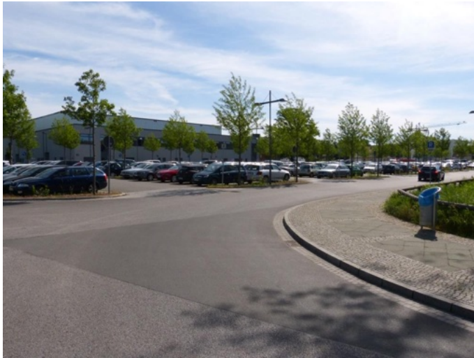
Blick von Westen auf neue Stadthalle mit dazugehörigem Parkplatz
