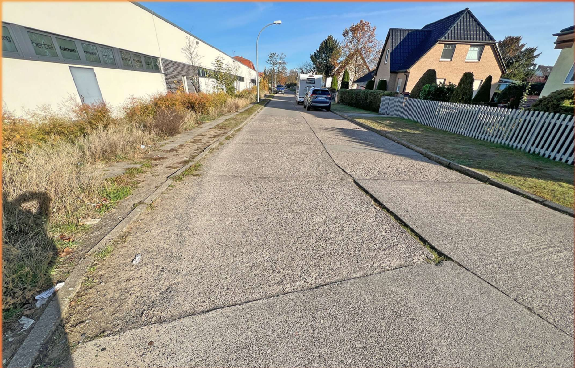
Schopenhauerstraße Blickrichtung Norden
